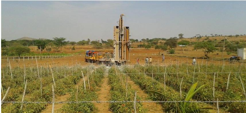
Photo 13: Forage d'un nouveau puits dans une exploitation irriguée (avril 2016)
